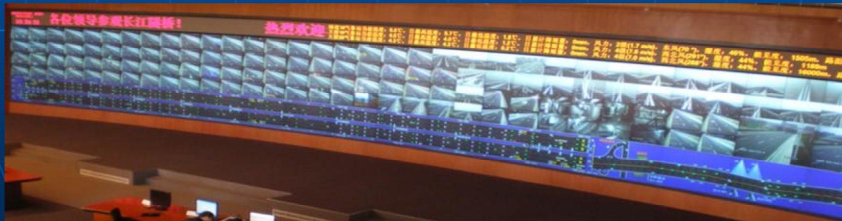
上海某隧桥监控项目 54面屏
